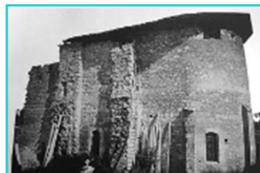
L'église avant les travaux du 19 e siècle (cf. Marquis de Fayolle, 1885)
